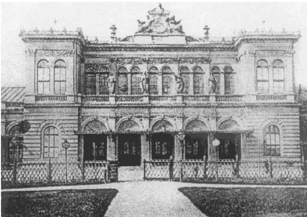
Abb. 14 Fassade des Ostbahnhofs 1870.
